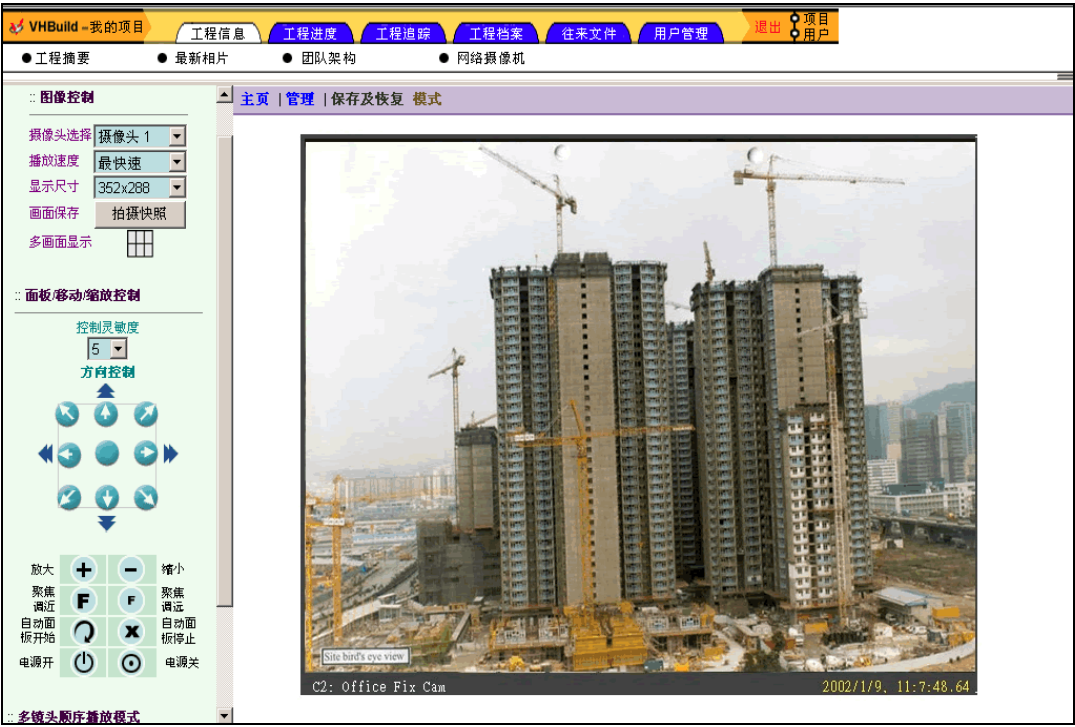
图 6 全天候、无地域限制地监视工地
